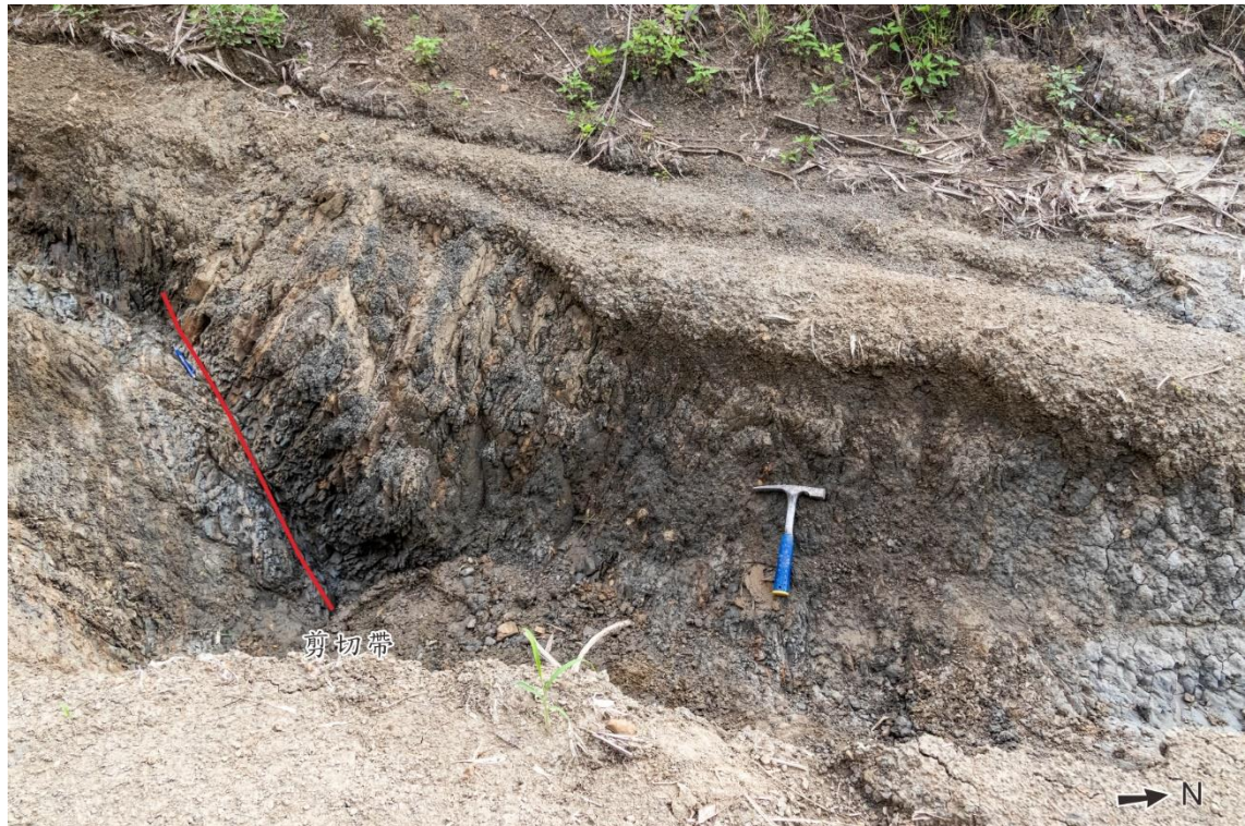
圖 24 走馬瀨農場南方裂開路面的露頭，露頭位置參考圖 21。剪切帶(紅色線處)截切過薄砂岩層。
